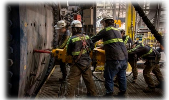
Figura 3 - Imagen referencial de desmontaje de pernos de revestimientos de los Molinos.
