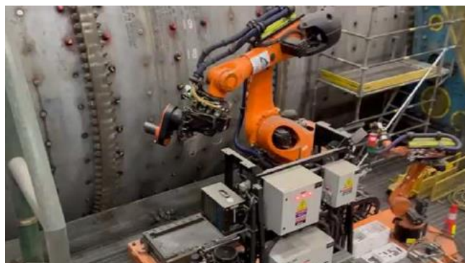
Figura 1. Brazo robótico articulado que automatiza el cambio de pernos en revestimientos de molinos.
